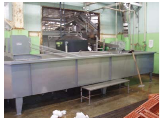
丸屠体冷却チラー槽
